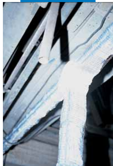
Пример разрушения бетонной конструкции
