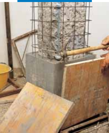
Удаление деревянной опалубки
