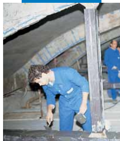
Заливка Mapegrout Hi-Flow в металлическую опалубку
