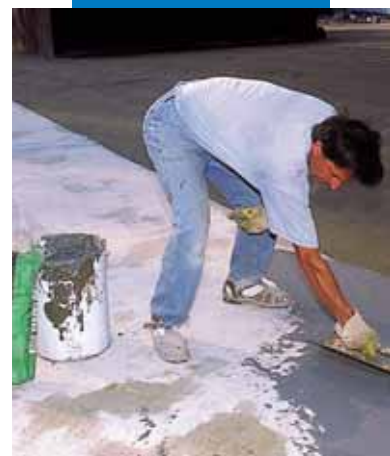
Гидроизоляция плавательного бассейна с помощью Mapelastic
