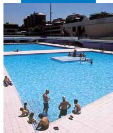
Плавательный бассейн, гидроизолированный с помощью Mapelastic: Scarioni Leisure Centre - Милан - Италия
